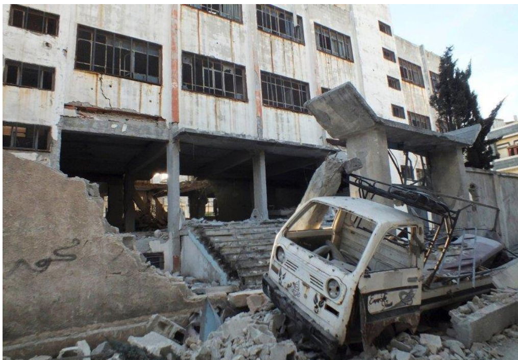
Skadad skolbyggnad och resterna av en pickup i staden Homs, 7 mars 2013
